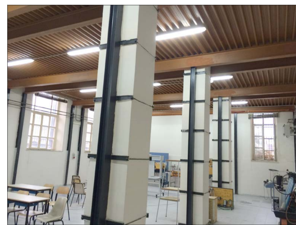
FOTO n° 1 Interno laboratorio meccanica a fluido
