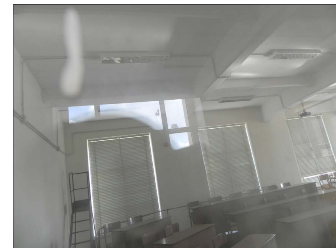
FOTO N. 3 - Stato di fatto
